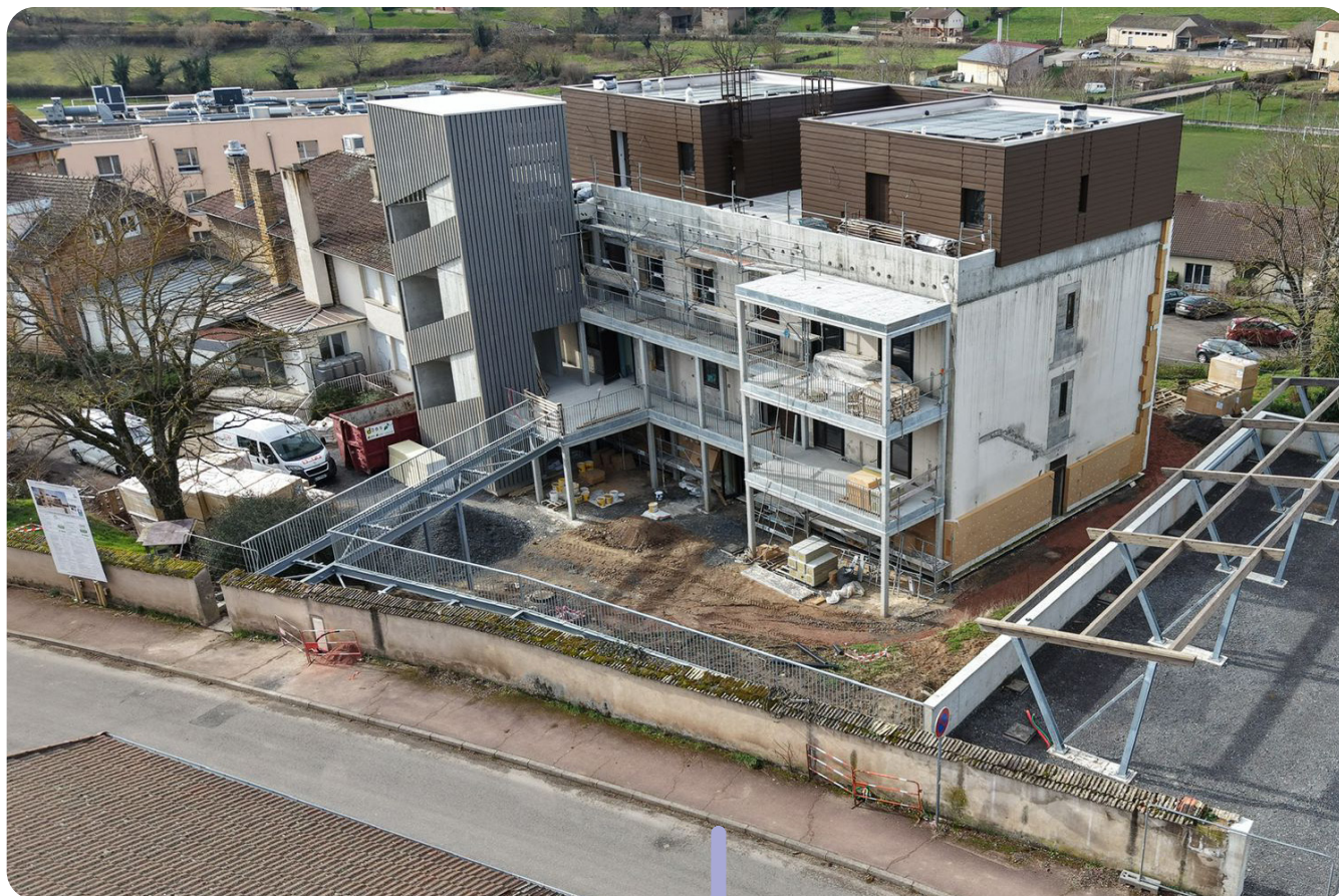
La résidence Les Terrasses de Corsin compte 11 logements locatifs, adaptés pour des seniors et des personnes à mobilité réduite.
